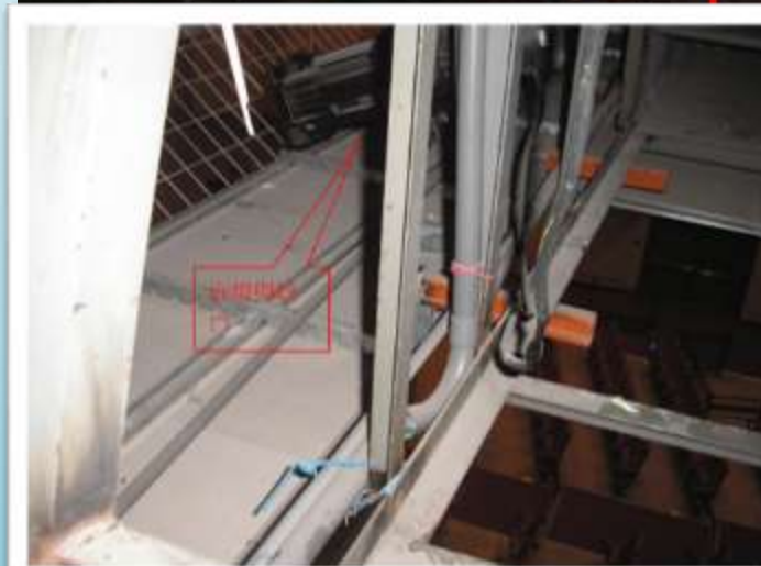
照片 2 縱向與橫向交會處長一點五公尺、寬零點七公尺的缺口未鋪設鐵板，缺口四周以欄杆作為護圍(兼具上下貓道之設施)，罹災者跨越護欄，從缺口處墜落。
